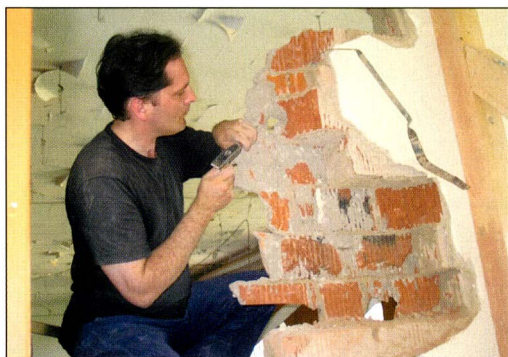
Entfernung des Restmauerwerks
