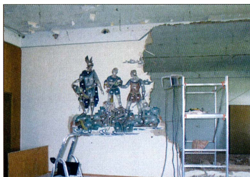
Ausbau des ersten Wandbildes mit der Nibelungensage
