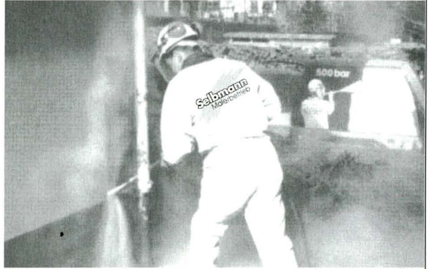
Entfernung von Altbeschichtungen
