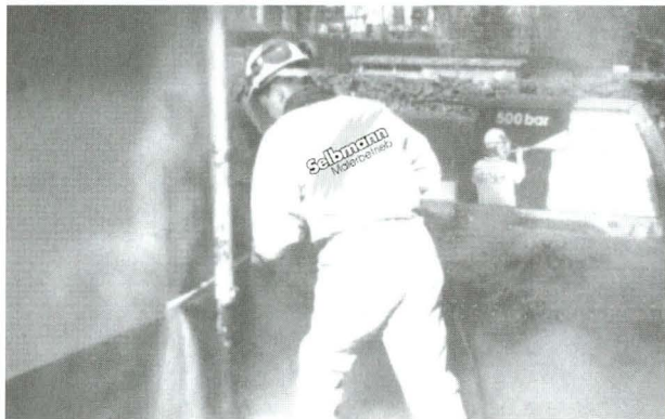
Entfernung von Altbeschichtungen
