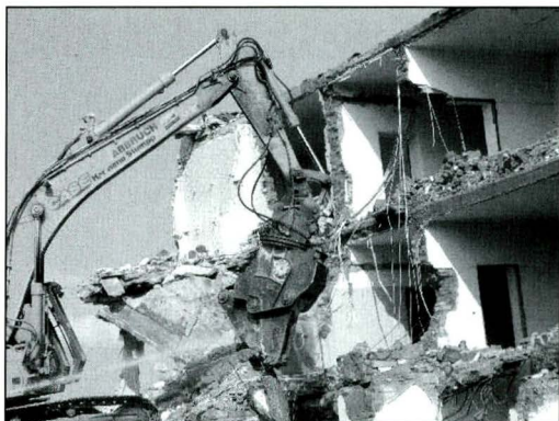
Bagger beißen sich durch die Gebäude
