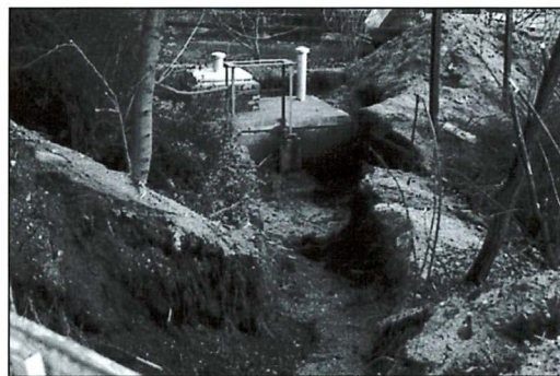
Verlegen der Wasserleitung
