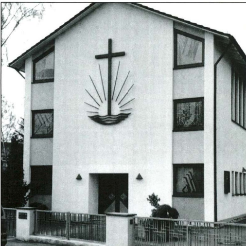
1956 – die neuapostolische Kirche war das erste Gebäude im „Stillen Winkel“, hier nach der Renovierung im Jahr 1992
