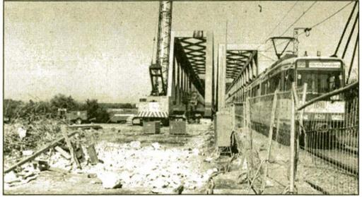
Die Brücke wird in Kürze auf die Widerlager abgesenkt, während die ausgedienten Montagefundamente bereits entfernt wurden. An dieser Stelle werden später die neuen Gleise verlegt.
