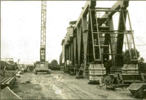
Das letzte 150 Meter lange Teilstück der zweiten Bahnbrücke wird auf der badischen Seite zusammengeschweißt.
