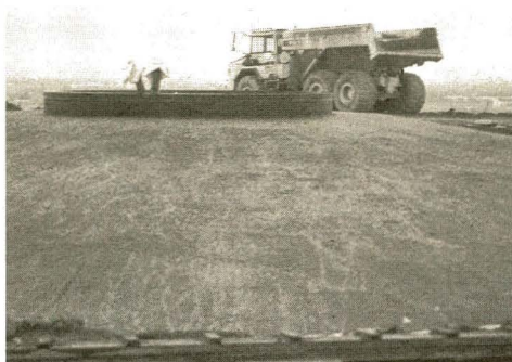
2) Fundament: 350 Kubikmeter Beton wurden auf 45 Betonlastern transportiert
