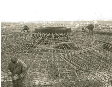
1) Fundament: 16 Tonnen Baustahl und 6 Tonnen Segment
