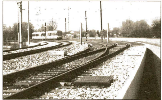
In der Abstellgleisanlage wenden ab 30.5. die Stadtbahnwagen der Linie S5.
