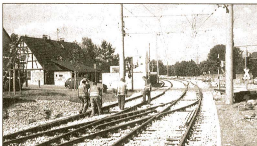
Neue Weichen im Fahrgleis der Stadtbahn an der Rheinbergstraße bringen für die Anwohner weitere Lärm- und Erschütterungsbelästigung.
