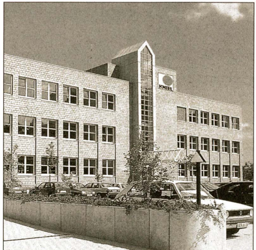
Blick auf den Neubau der Kniel Firmengebäude
