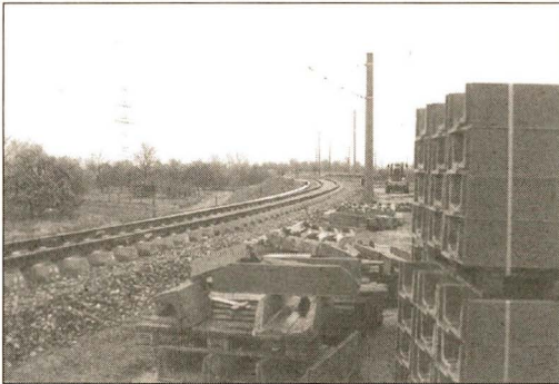
Bauarbeiten 1.4.97 Blickrichtung Alb
