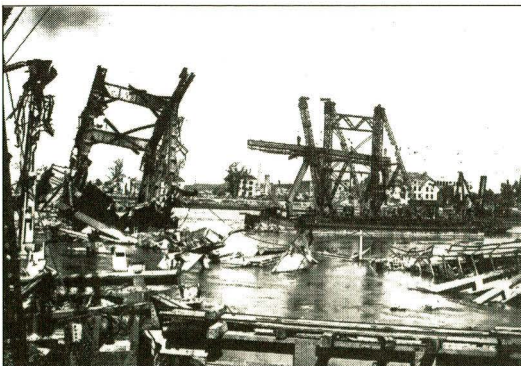
Die zerstörte Rheinbrücke wird demontiert
