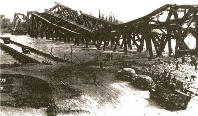
Zerstörte Rheinbrücke Maxau, mit Behelfsbrücke
