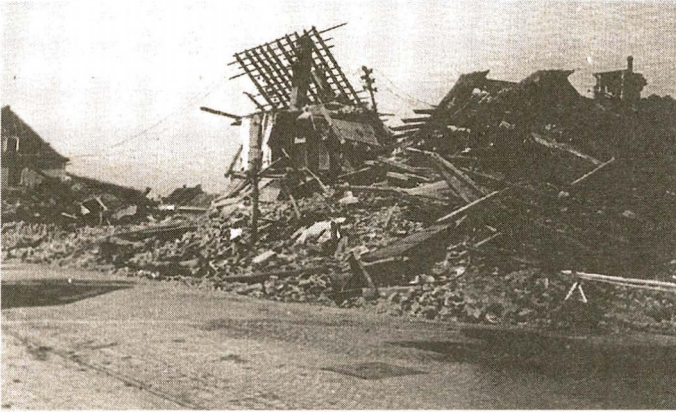
Saarlandstraße Höhe „Eisen-König“, rechts im Bild ehemaliges Postgebäude (3 Tote)
