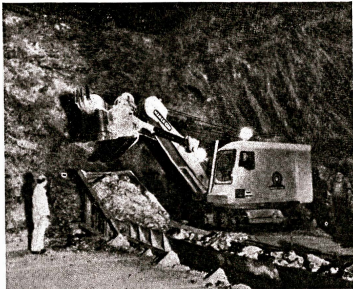
Löffelbagger im Einsatz
