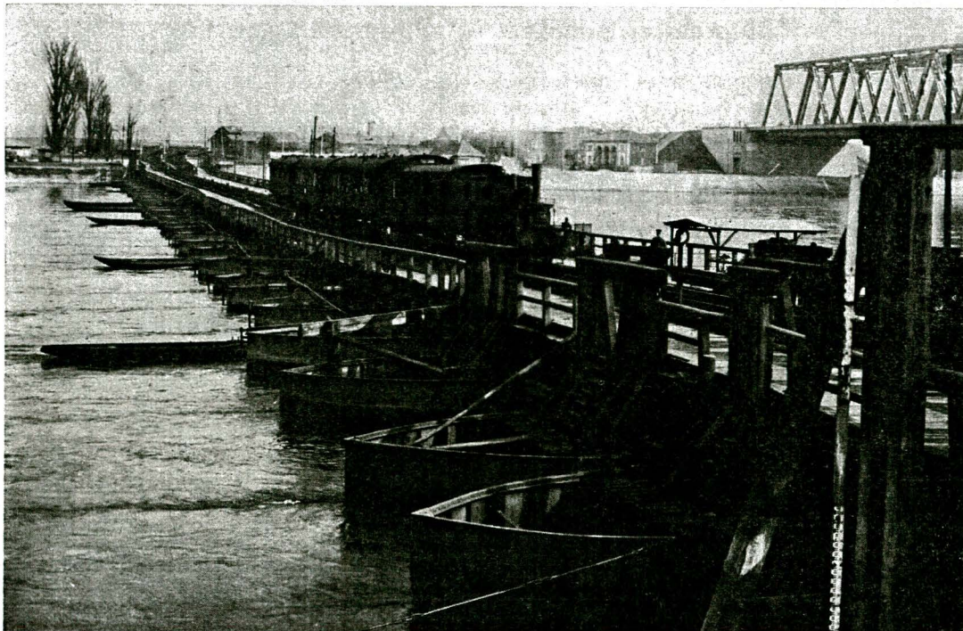
Im kommenden Jahr wird die vierte Rheinbrücke bei Knielingen-Maxau eingeweiht. Aus diesem Anlaß möchten wir Ihnen ein bereits historisch gewordenes Bild der ersten und der zweiten Rheinbrücke in Erinnerung bringen.
