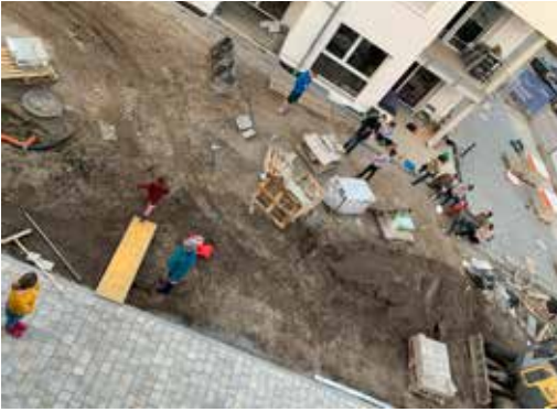
Foto 3: Der Garten ist noch Baustelle, aber wir treffen uns dort schon mal nach Feierabend zum Austausch und zum Spielen - Foto Mitte März 2025, zwischen den beiden Häusern
