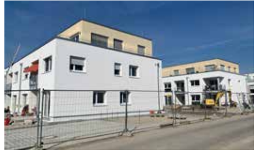
Foto 2: Die Baustelle wandelt sich zu bewohnten Häusern – Foto von Anfang März 2025
