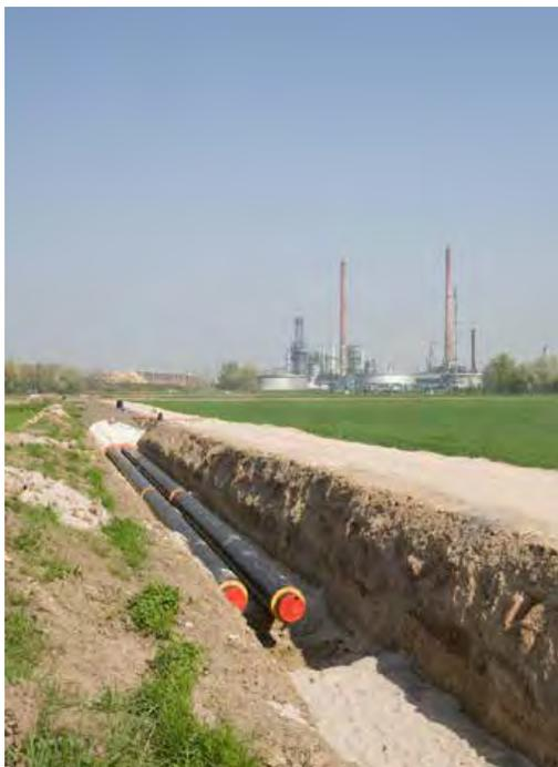
Von der Raffinerie in die Wohnungen. Um die Abwärme der MiRO zu transportieren, verlegten die Stadtwerke eine fünf Kilometer lange Transportleitung. Sie verbindet die Raffinerie mit dem Heizkraftwerk West, der Zentrale der Fernwärmeversorgung der Stadt Karlsruhe. Von dort aus erfolgt die Weiterverteilung in das Karlsruher Stadtgebiet und nach Rheinstetten. Foto: Stadtwerke Karlsruhe
