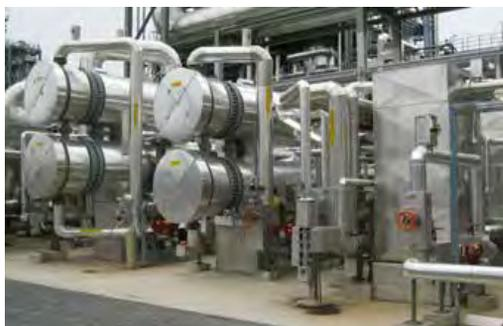
Um die Prozessabwärme der MiRO einzusammeln, wurden hochmoderne Wärmetauscher auf dem Raffineriegelände installiert. Foto: MiRO
