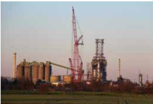
In der Raffineriewelt spricht man zwar von „Stillstand“, aber still stehen bei einer Großinspektion nur die Anlagen, drum herum herrscht Hochbetrieb. Sie werden gereinigt, falls erforderlich repariert, technisch noch weiter optimiert und vom TÜV überprüft. Die Arbeitsliste bei dieser TÜV-Inspektion ist lang: 6 Großmaschinen, 700 Apparate und 600 Armaturen und Sicherheitsventile müssen unter die Lupe genommen sowie alles in allem 1.000.000 Arbeitsstunden von der Mannschaft geleistet werden.
