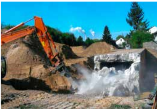
Bunker Elsternweg Abräumung
