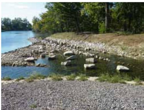
Das kombinierte Auslaufbauwerk (oben das eigentliche Auslaufbauwerk) hält den Seewasserspiegel auf einem mittleren Niveau und verhindert das Zuströmen sauerstoffarmen Grundwassers. Das Fischverbindungsgewässer erlaubt die Fischmigration in den Willichgraben auch bei niedrigen Wasserständen (September 2015).
