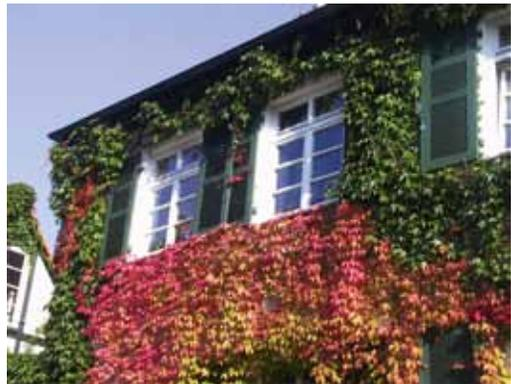
metik an sanierungsbedürftigen Mauern oder Fassaden eingesetzt werden, um einen netten Anblick zu haben. Haftwurzeln und Näpfe dringen dann in Risse und Löcher ein und bereits bestehende Schäden können dadurch verstärkt werden. Bei einer intakten Fassade findet hinter Blattwerk eine Luftzirkulation statt, so dass sich keine Feuchtigkeit bilden kann. Darum ist oberstes Gebot für eine Fassadenbegrünung ein intaktes Mauerwerk
