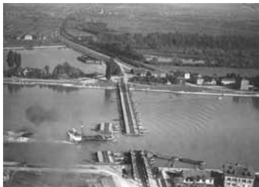
Brücke geöffnet für die Passage der Schiffe
