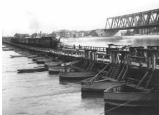
Brücke geschlossen für den Zugverkehr
