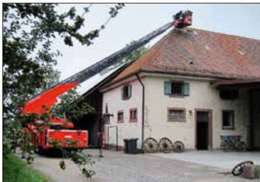
Unterbau Storchennest prüfen
