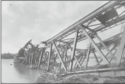
Zerstörte Brücke Maxau 1945
