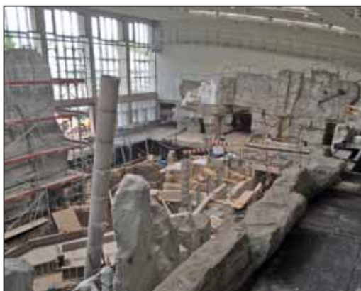
Nach den Roharbeiten gibt es bis zur Fertigstellung des Exotenhauses im Frühjahr 2015 noch viel zu tun. (Foto: C. Becker; September 2014)
