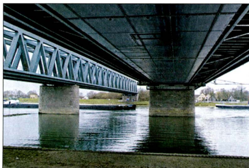
Die heutige Straßenbrücke Maxau ruht auf einem einzigen tragenden Kasten - Nachteil bei Sperrungen (Foto U. Fien)
