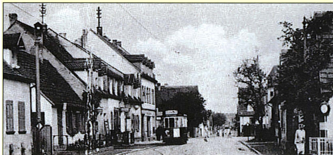
Blick Saarlandstraße in Höhe Gasthaus „Rebstock“
