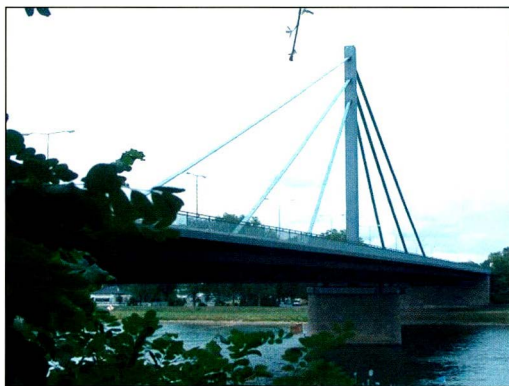
Rheinbrücke Karlsruhe Wörth
