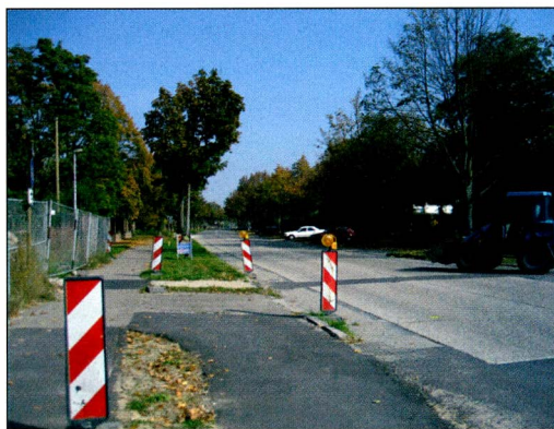
Zwischen der Ludwig-Dill-Straße und der Annweilerstraße wird auf der Sudetenstraße im Rahmen der Konversionsbaumaßnahmen ein neuer Straßenbelag aufgebracht.
