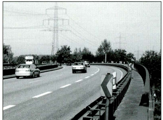
Der 500 m lange Standstreifen über die Südtangentenbrücke wird als Einfädelspur für den Schwerlastverkehr ausgebaut.
